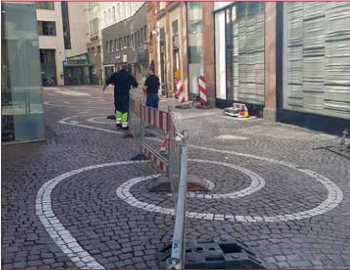
Baustellen Vorbereitung | Building site preparation
