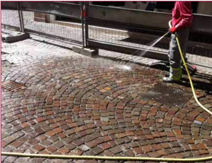
Reinigung der Steinoberfläche | Cleaning the stone surface
