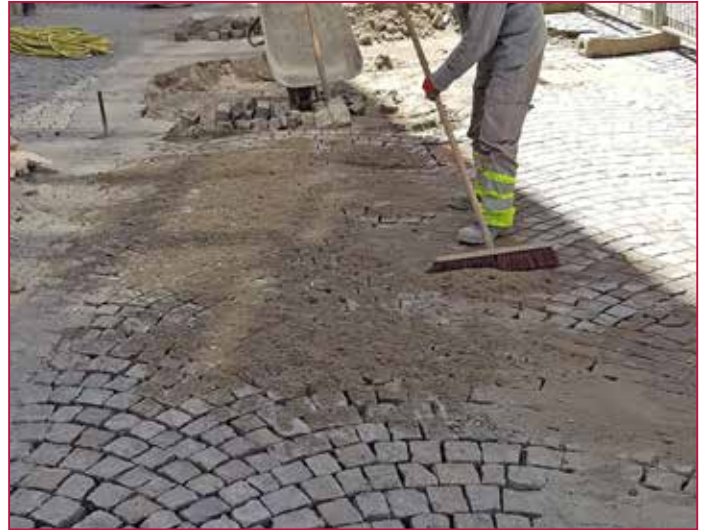
Auffüllen der Fuge | Filling the joints
